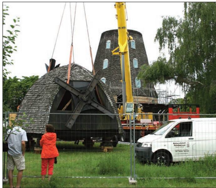
Ein Kran nahm die Kappe (Dach) der Britzer Mühle ab, setzte sie dann vorsichtig auf hölzerne Sockel auf dem Boden der Streuobstwiese.
