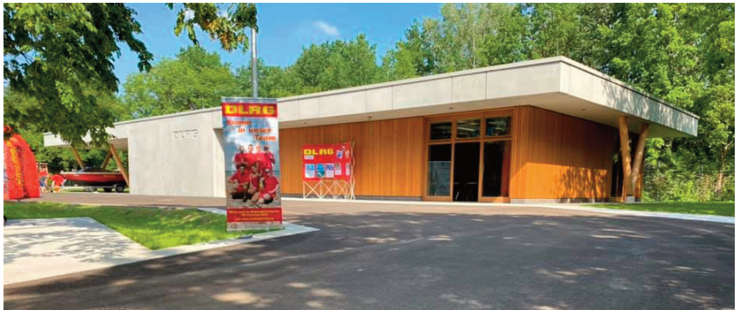
Der eingeschossige Neubau in der Severingstr. beherbergt einen Schulungs- und Veranstaltungsbereich, eine Werkstatt mit Lager und die Räume der Geschäftsstelle. Fotos: DLRG
